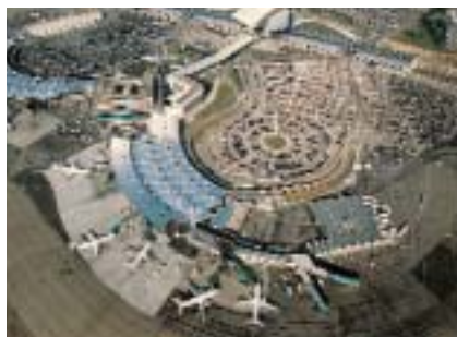
Aéroport de Lyon - St Exupéry
